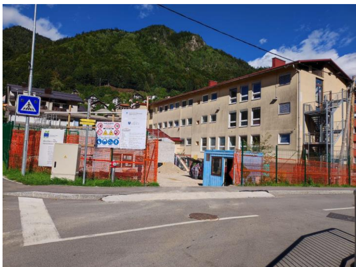
Gradbišče ob šoli
