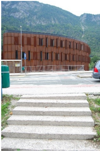
Prehod za pešce pri Občini Jesenice (gost promet)
